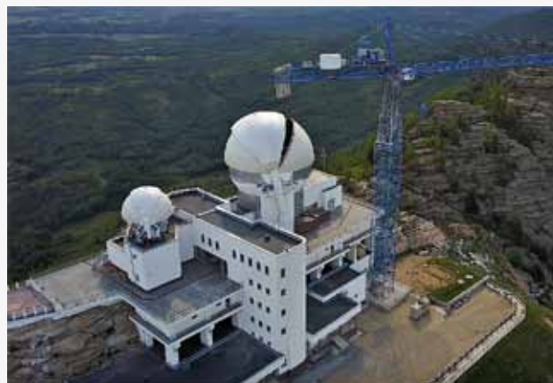
Рис. 2. Алтайский оптико-лазерный центр (2-я очередь), справа башня телескопа ТИ, диаметр 3,1 метра
