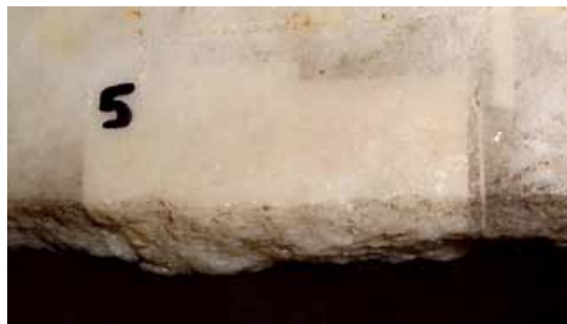
Рис.7. Очистка мрамора от загрязнений Fig.7. Marble cleaning of pollutants
