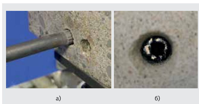
Рис.5. Комбинированный лазерно-механический метод бурения: а) механическая обработка; б) отверстие (диаметр 10 мм) в бетоне (толщина 35 мм)
